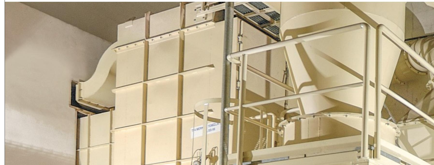
Projelendirme aşamasında, üretim sahasında kömür tozunun da bulunmasından dolayı sisteme patlama kapakları, yanık algılama ve söndürme ekipmanları dahil edilmiştir.
