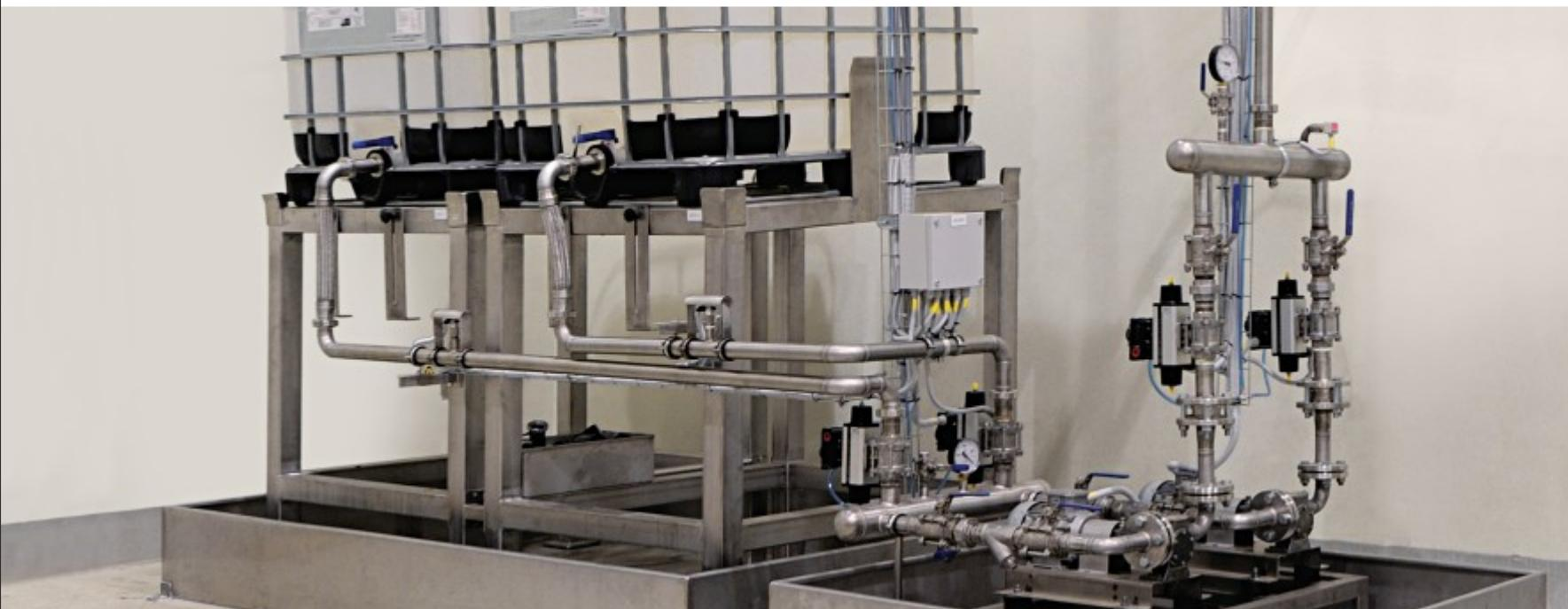
Özel seçilmiş pompalar vasıtası ile sistem hava yapmayacak şekilde ve tüm hat boyunca gerekli basıncı sabit bir değerde tutabilecek otomasyonu ile birlikte üst seviyede enerji verimli olarak tasarlandı.
